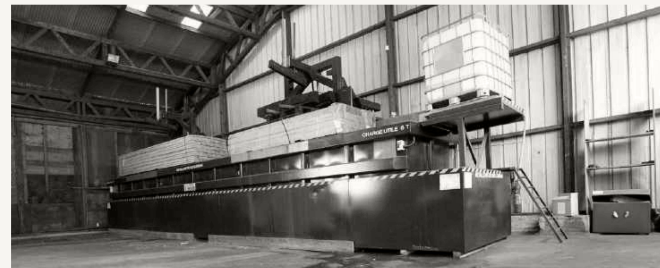
Bac de préservation Classe 2 - Site de Bouguenais (44)
